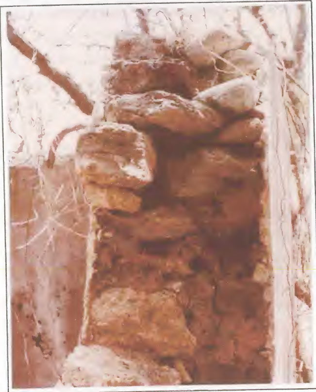
Foto 2.12. 1980 Muur opgebouwd uit brokken breuksteen. Duidelijk is te zien dat deze uit twee, naast elkaar ge- plaatste, rijen op- gebouwd is. (foto: M. Newton)
